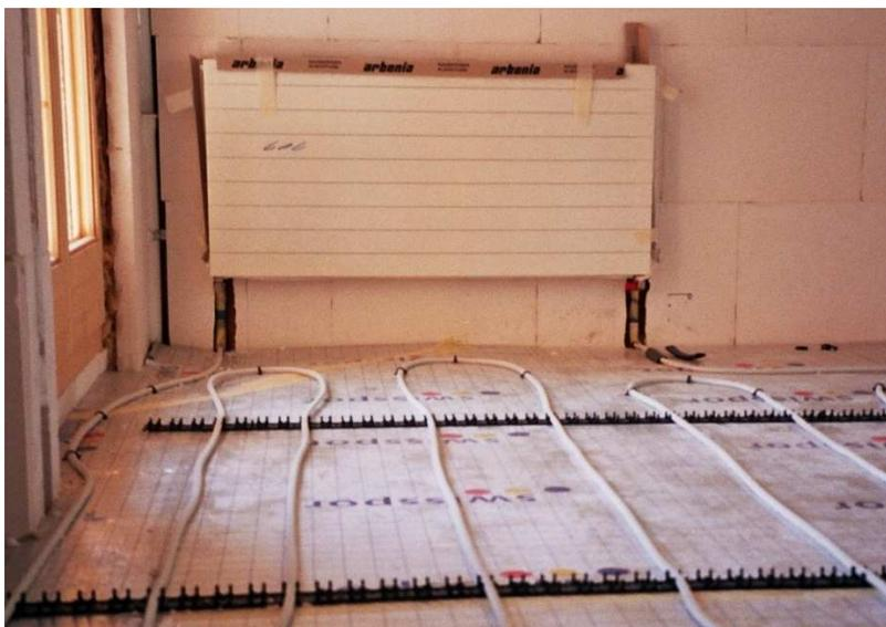
*Boucles de chauffage au sol placées en sortie du radiateur*
