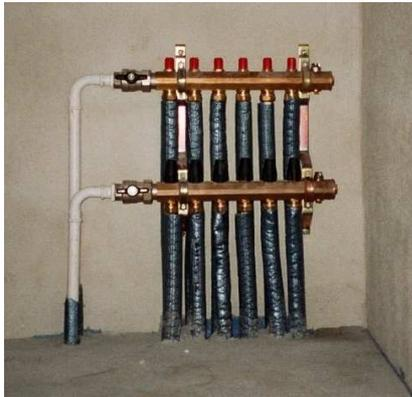
de chauffage par le sol. Le circuit de chauffage est constitué de tuyaux qui circulent à travers les pièces, ils sont alimentés par trois collecteurs situés au rez-de-chaussée pour l'un, et au premier étage pour les deux autres (ci-contre le collecteur du rez-de-chaussée). Ces collecteurs reçoivent l'eau chaude de la pompe à chaleur, la distribuent dans le circuit de chauffage et la récupèrent à la sortie pour la renvoyer vers la pompe à chaleur.
