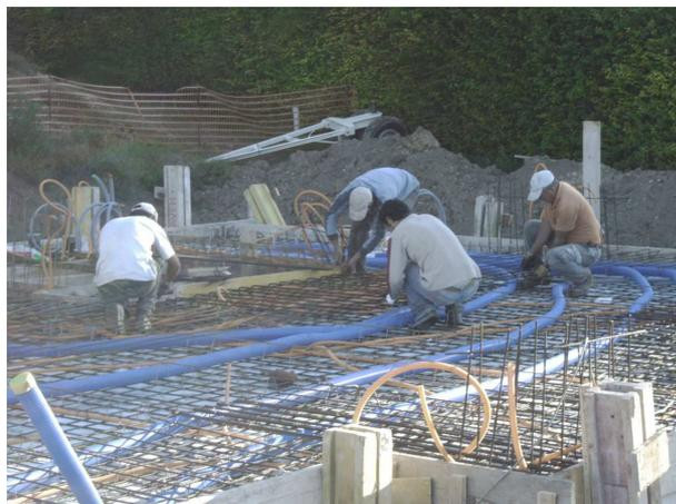
*Fig. 12 : Les gros tuyaux bleus sont les tuyaux VMC et sont en train d'être solidement accrochés pour ne pas bouger lors du coulage de la dalle*
