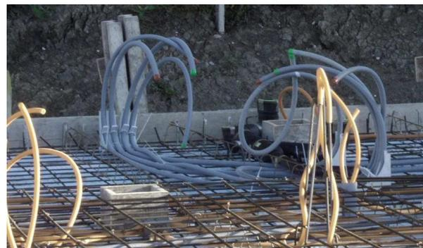
*Fig. 14 : On voit ici les arrivées d'eau avec des bouchons rouge pour le chaud et vert pour le froid ainsi que les écoulements eaux usées en noir (GEBERIT). Les tuyaux oranges sont ceux de l'électricien .*
