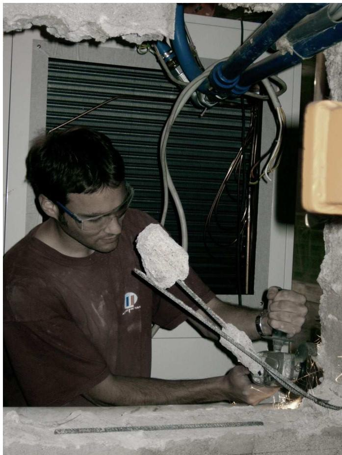
Fig.6 : Aménagement de trous dans les murs pour l'installation de gaines
